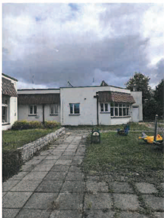
Fot. 3 – Fragment elewacji południowej- zachodniej- - widoczne łamacze światła, które będą demontowane
